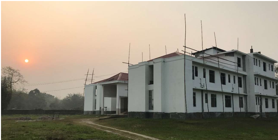
Bild: Gebäude in der Errichtungsphase
